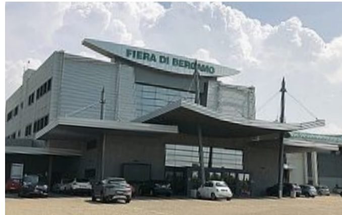
L'immobile Promoberg gestisce gli spazi realizzati nel 2003 in via Lunga
